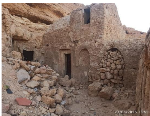
صورة توضيحية شكل رقم (2) توضح من عيوب ترميم أبواب البيوت استخدام الخشب
