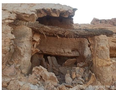
صورة توضيحية شكل رقم (1) توضح طريقة التسقيف بجذوع النخيل
