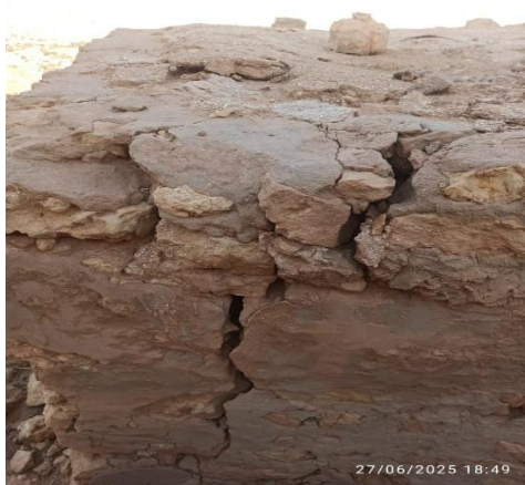
صورة توضيحية شكل رقم (9) توضح تشققات راسية وأفقية في الجدران
