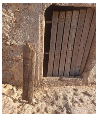
صورة توضيحية شكل رقم (2) توضح من عيوب ترميم أبواب البيوت استخدام الخشب
