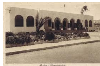
صورة (3) لمبنى المتصرفية
